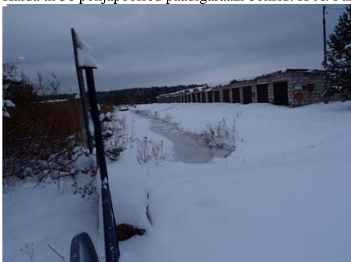
Foto 5. Vaade juurdepääsuteelt kanali idapoolsele harule ja Kalda tn 36 paadigaraaži boksidele. K-A. Parksepp 11.11.2016.
