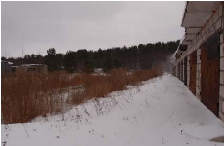
Foto 3. Vaade Kalda tn 32 põhjapoolse paadigaraaži boksi eest kanalile. K-A. Parksepp 11.11.2016.
