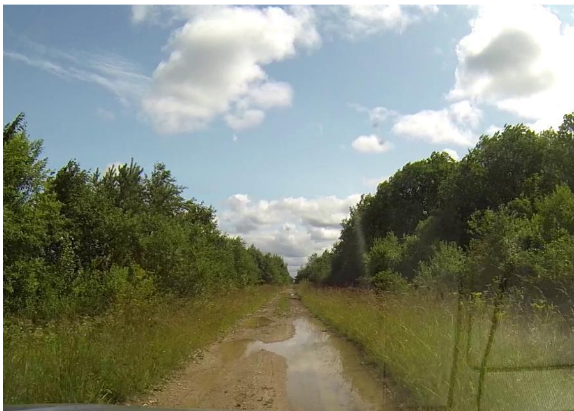
Pilt 34. 8511050 Laidu tee, peenrad kõrged, vajadus lisada kruusmaterjali, profileerimine
