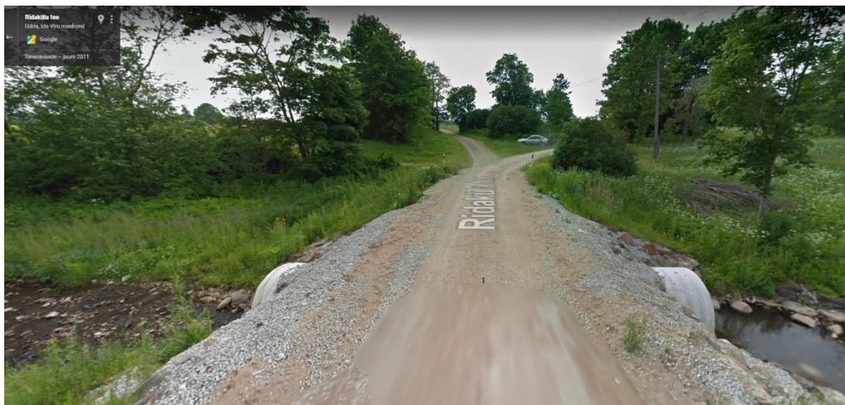
Pilt 14. Silla asemel rajatud truup üle Udria oja teel 8510550 Ridaküla tee (kuvatõmmis GoogleMaps andmekogust, pildistamise aeg juuni 2011).
