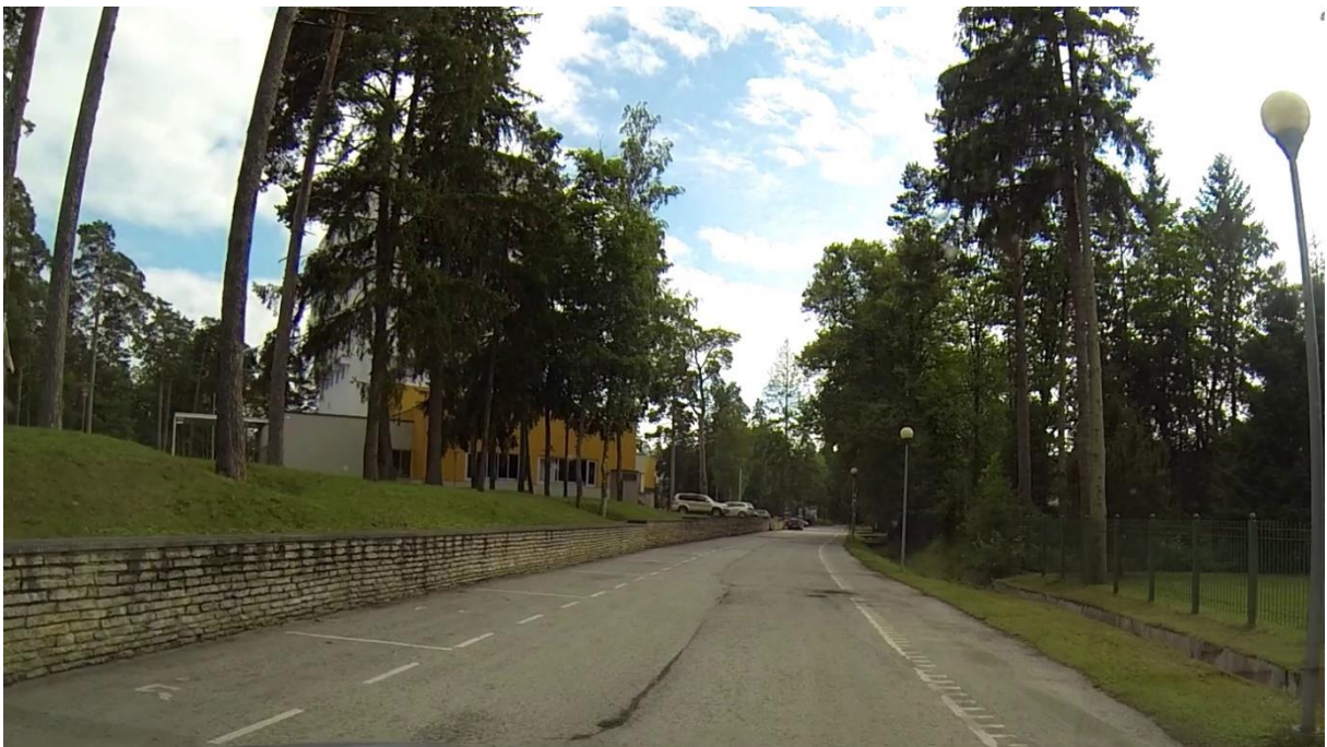
Pilt 9. 5130002 Aia tänav km 1,5 tolmuva kate, seisukord halb
